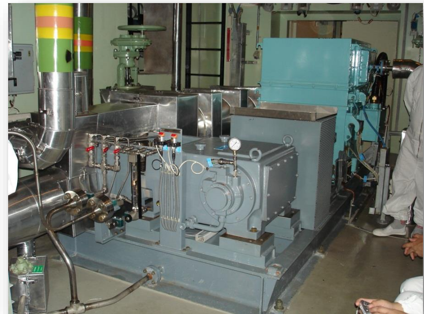
Instalace zařízení v Číně, před zahájením produkce
