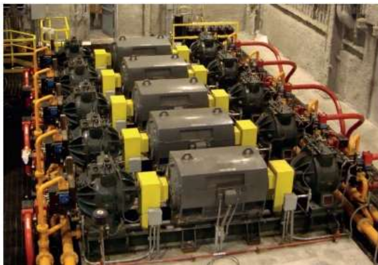
Pohon PMSD s 10 čerpadly RX pro kovací lis 53MN.
